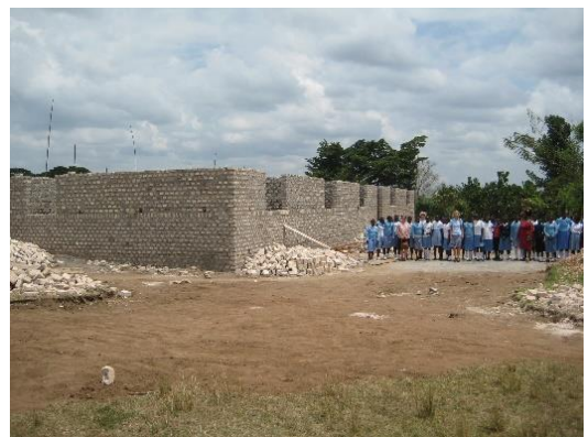
Hier entsteht das neue Mädcheninternat
