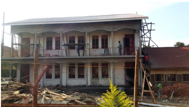
An der Stelle des alten maroden Klassenraumblocks steht nun ein solides zweigeschossiges Gebäude
